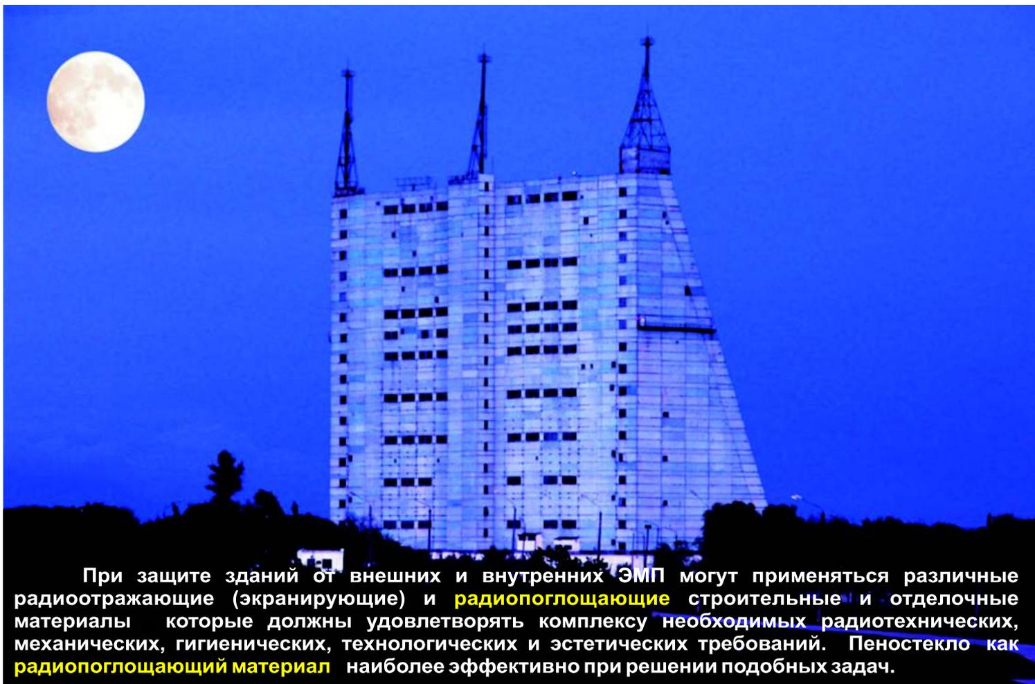
При защите зданий от внешних и внутренних ЭМП могут применяться различные радиоотражающие (экранирующие) и **радиопоглощающие** строительные и отделочные материалы которые должны удовлетворять комплексу необходимых радиотехнических, механических, гигиенических, технологических и эстетических требований. Пеностекло как **радиопоглощающий материал** наиболее эффективно при решении подобных задач.
