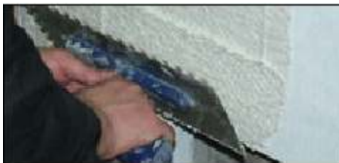
Внешний вид фрагмента фасадной системы с теплоизоляцией из минераловатных плит.
